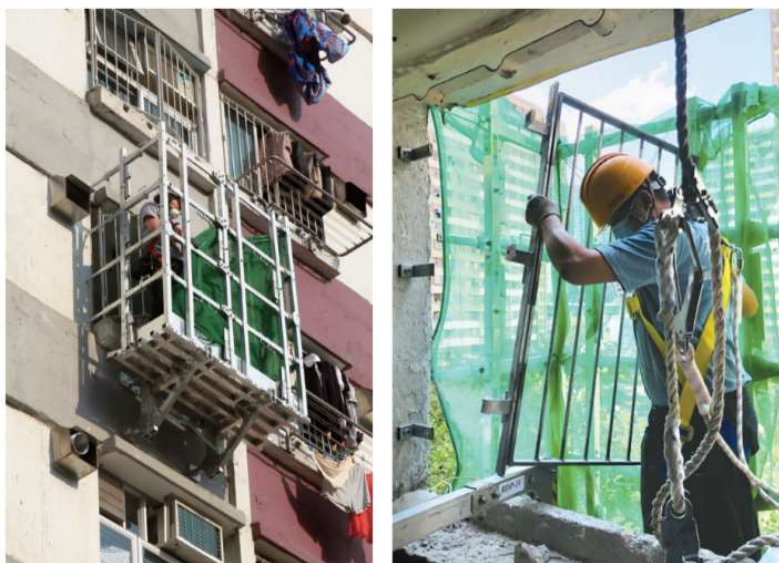
图 25：快速安装工作平台 (取自职安局网站)
