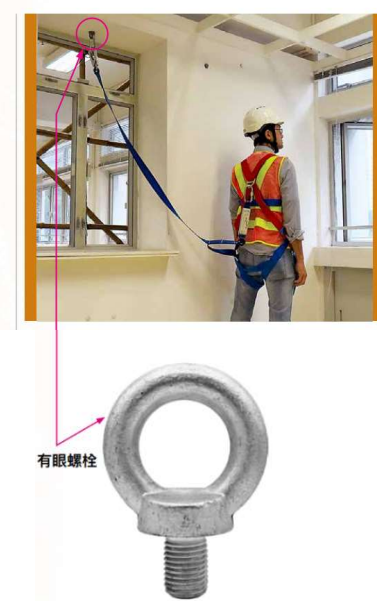
图 8：有眼螺栓及工人使用有眼螺栓时的情况 (取自劳工处的《悬空式竹棚架构造及工作安全指南》)
