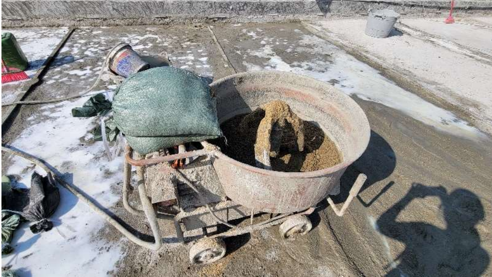
图 3：电动搅拌机开泥时未有使用安全罩 (由公署人员于 2024 年 1 月拍摄)
