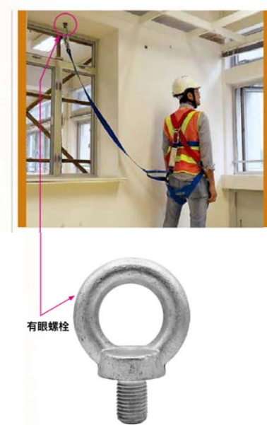
圖 8：有眼螺栓及工人使用有眼螺栓時的情況 ( 取自勞工處的《懸空式竹棚架構造及工作安全指南》 )
