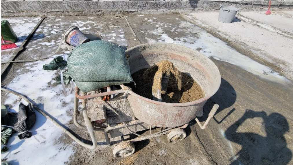
圖 3：電動攪拌機開泥時未有使用安全罩 (由公署人員於 2024 年 1 月拍攝)
