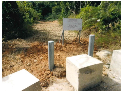
地政总署于 2020 年 11 月 在事涉地点竖立金属柱、 石屎趺及政府土地告示牌
