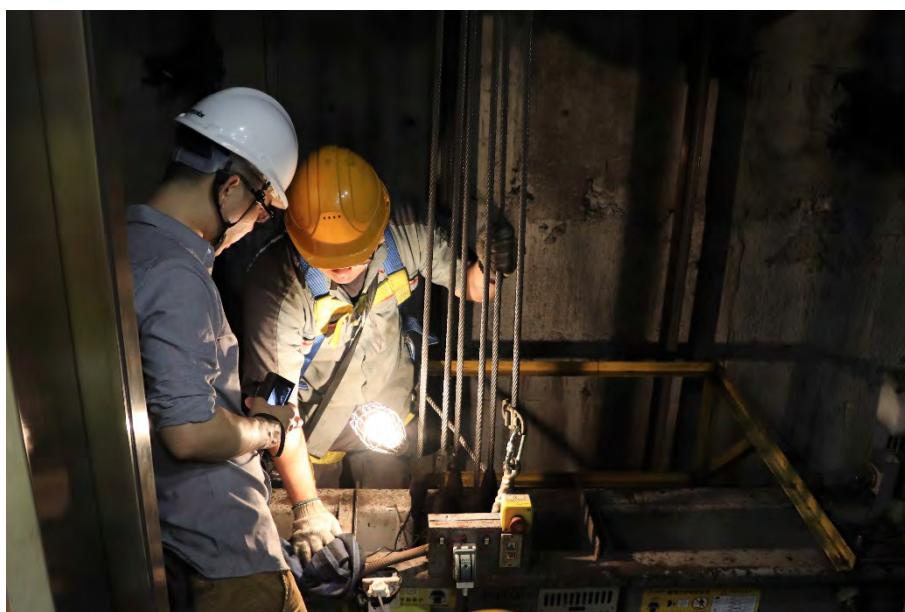
圖 1：機電署人員就升降機保養工作進行巡查
